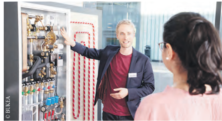
Die Begleitung durch die Hamburger Energielotsen kann dazu beitragen, dass Ratsuchende ihr Vorhaben erfolgreich beenden.
