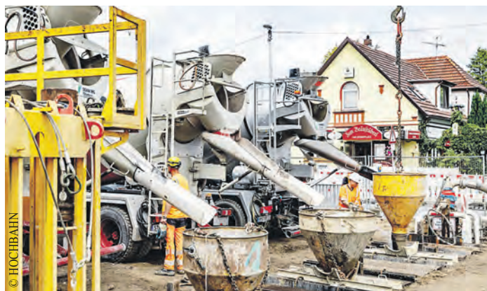
Die Arbeiten rund um den Bramfelder Dorfplatz kommen gut voran.
