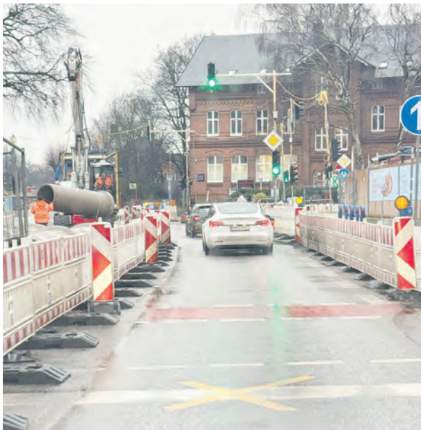
Für den Bau des Tunnels wird die Bramfelder Chaussee bis voraussichtlich Ende 2026 von bisher zwei Fahrspuren auf eine Spur je Fahrtrichtung eingeschränkt.
